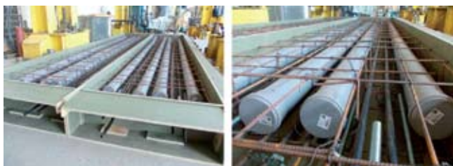
Rys. 6. Płyty „kanałowe” pomostu wagi przed zabetonowaniem
